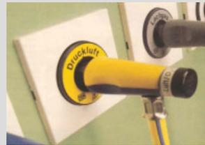
Erste Entnahmestellen mit geometrischer Gascodierung
